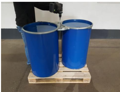
Schraube mit Akkuschauber in mittleren Palettenklotz einschrauben
